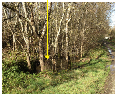
Après : L'eau a disparu une semaine après la mise en place de solutions d'étanchéité.
