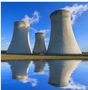
Cheminées par lesquelles sort la vapeur d'eau.
